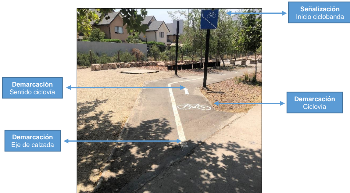
Figura 5. Demarcación y señalización situación actual
